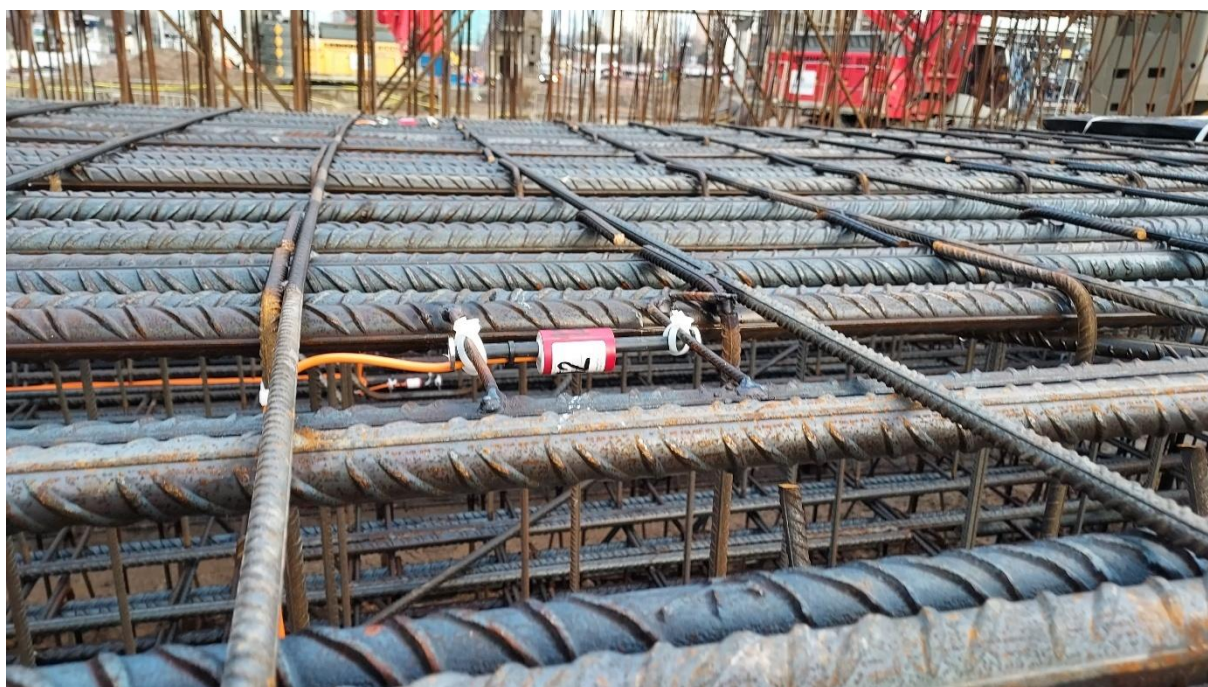
Rys. 5.24 Montaż czujnika nr 12 w szkielecie L388 (fot. Autora)
