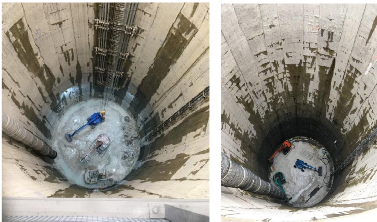
Rys. 2.11 Szyb technologiczny w Wielkiej Brytanii (fot. Bachy Soletanche Ltd.)
