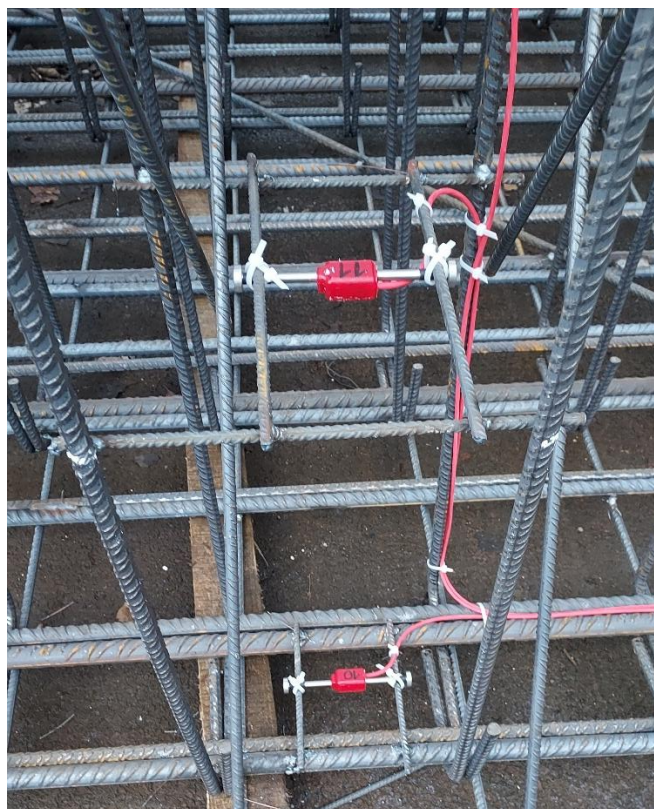
Rys. 5.18 Czujniki 10 i 11 w koszu A77 w zakładzie zbrojarskim (fot. Autora)
