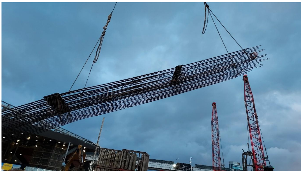
Rys. 5.1 Transport szkieletu zbrojeniowego z czujnikami (fot. Autora)
